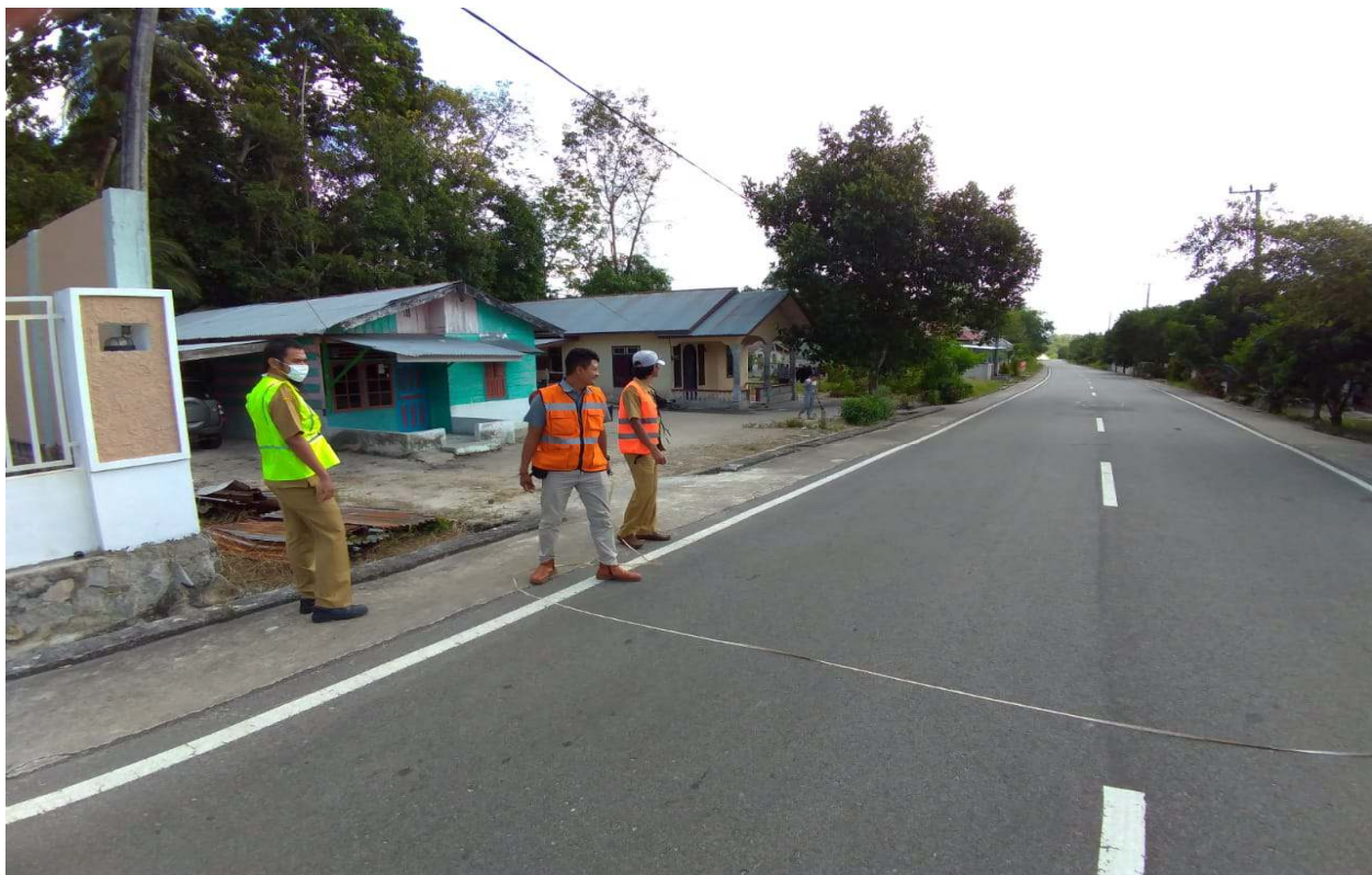
Ket : Pengukuran Lebar Perkerasan
