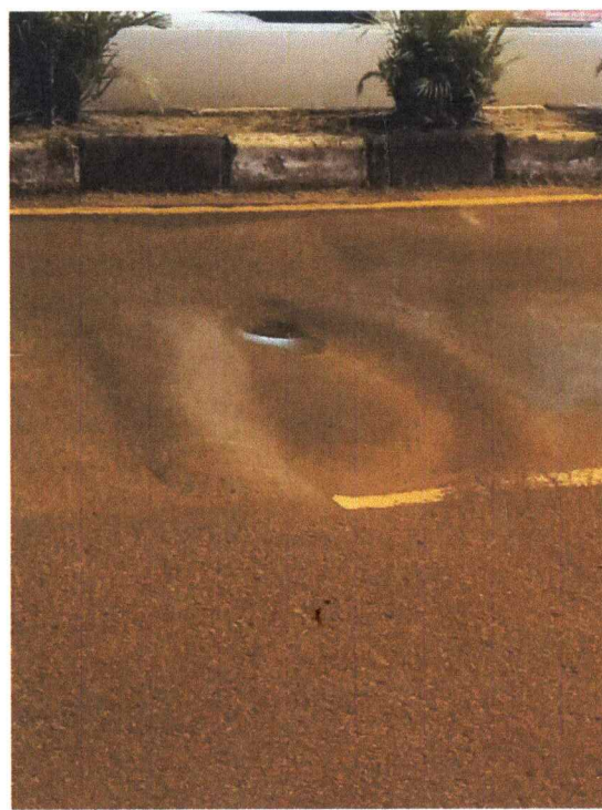
Pengaduan masyarakat mengenai jalan berlubang di depan Toko Andila Air Rayak telah dilakukan perbaikan
